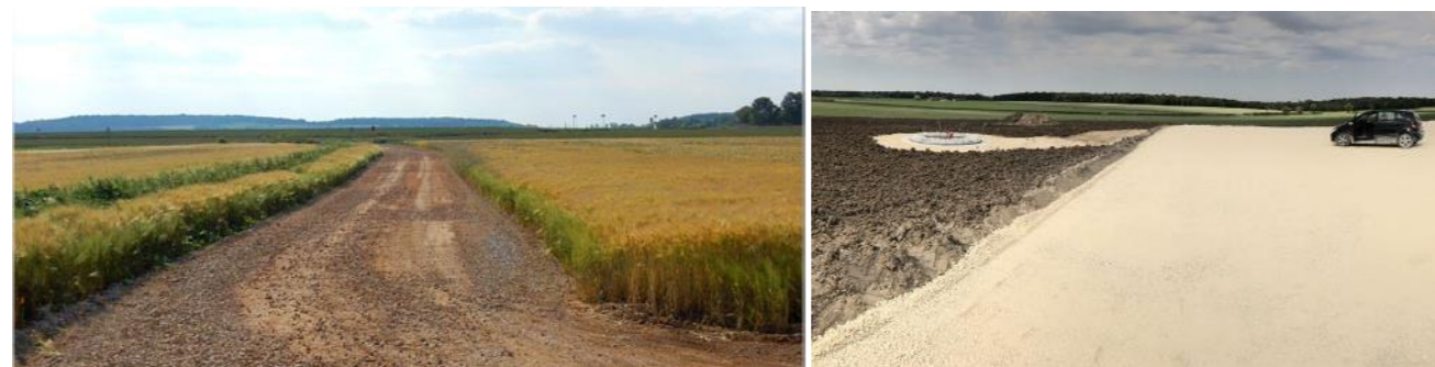
Un exemple de voie d'accès à un parc éolien (à gauche) et d'aire de grutage (à droite)
