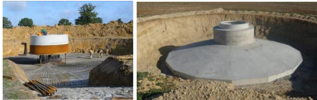
le ferrailage et le coulage d'une fondation d'éolienne
