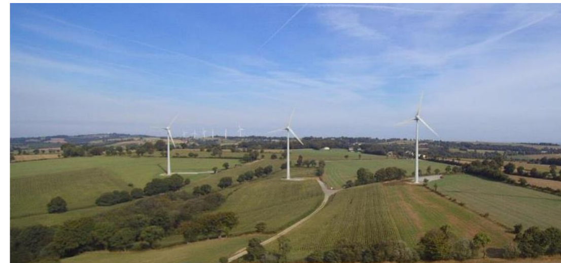
Figure 2 : un parc éolien en exploitation (AEPE gingko)
